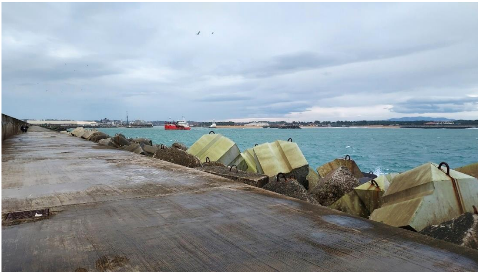
Digue de Tarnos
