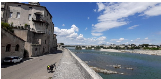
Pont-Saint-Esprit – 1 er août 2021
