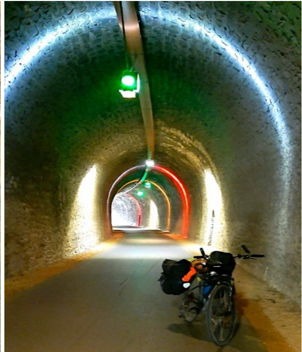
Voie verte vers Beaucaire (ancien tunnel ferroviaire)
